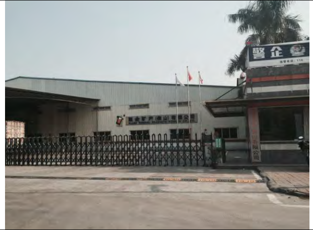
项目南面 联合矿产(佛山)有限公司
